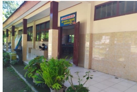
Laboratorium Tampak Luar
