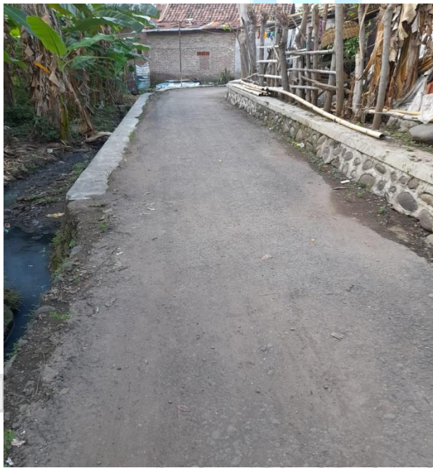
Foto jalan yang telah dilebarkan
