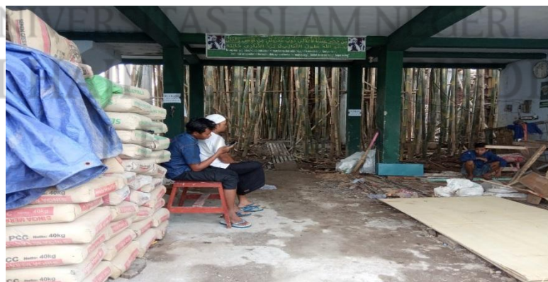
Gambar 4.3 Bahan Material yang di sediakan untuk Renovasi. 93
