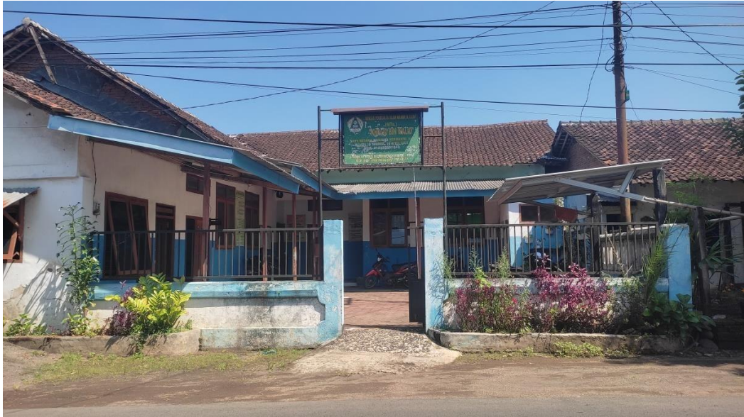
Gedung kelas putra
