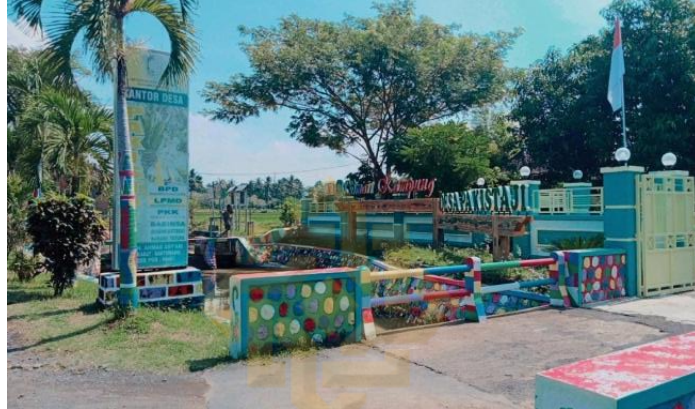
Gambar 4.2 Kantor Desa Sesudah Renovasi
