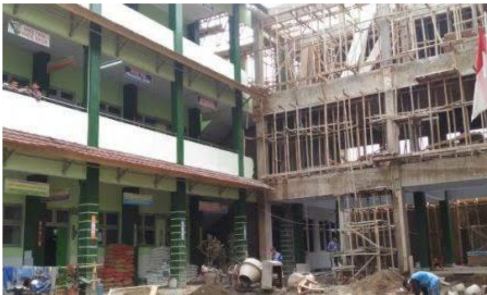
Gambar 4.2 Pembangunan RKB (Ruang Kelas Baru). 77
