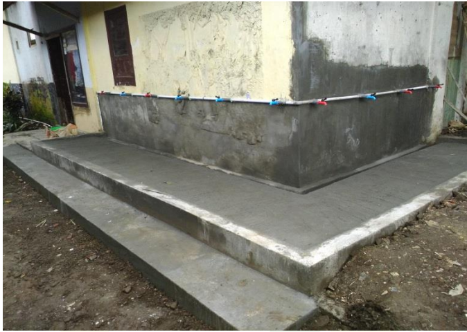
Pembuatan tempat wudlu berjumlah sepuluh kran air
