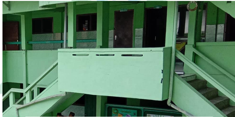
Gedung Madrasah Aliyah Ashri Jember
