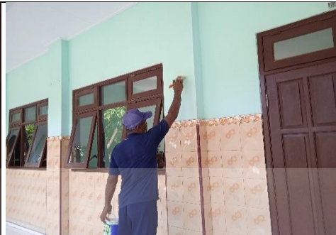
Pemeliharaan bangunan pengecatan
