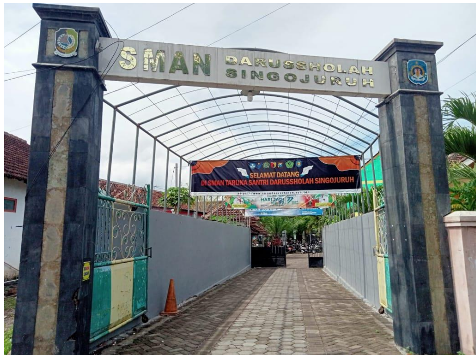
Gambar 4.1 Gapura depan SMAN Darussholah
