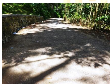
Gambar 4.6 Kondisi Jalan menuju wisata
