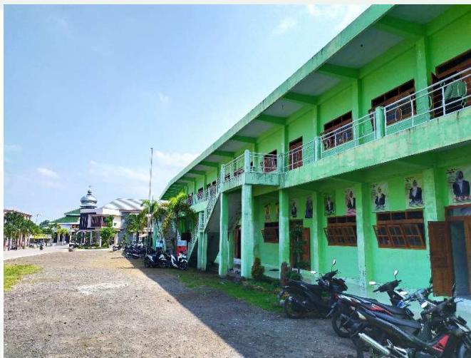
Gedung SMA Nuris Jember
