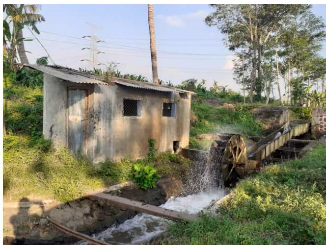
Gambar 4.1 PLTA (Pembangkit Listrik Tenaga Air)
