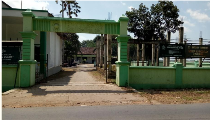
Gapura Pintu Masuk Madrasah
