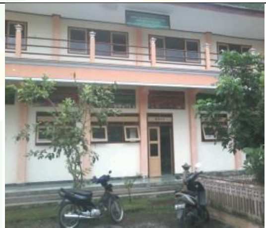
Gedung paket CPKBM Asy-Syifa' (lantai bawah ruang kelas, lantai atas kantor dan perpustakaan)
