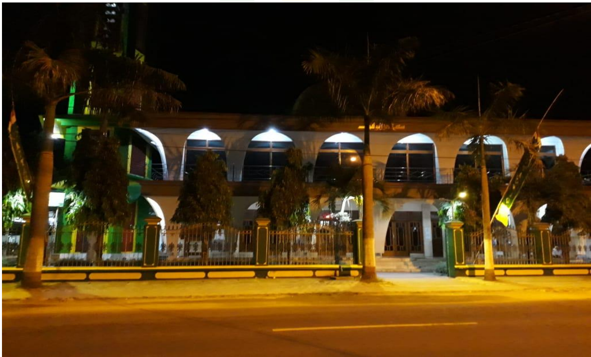
Gambar 10: tampak bangunan masjid At-taufiq dari depan
