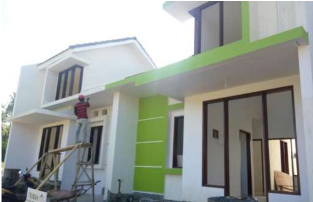
Pembangunan Rumah Griya Masangan Indah
