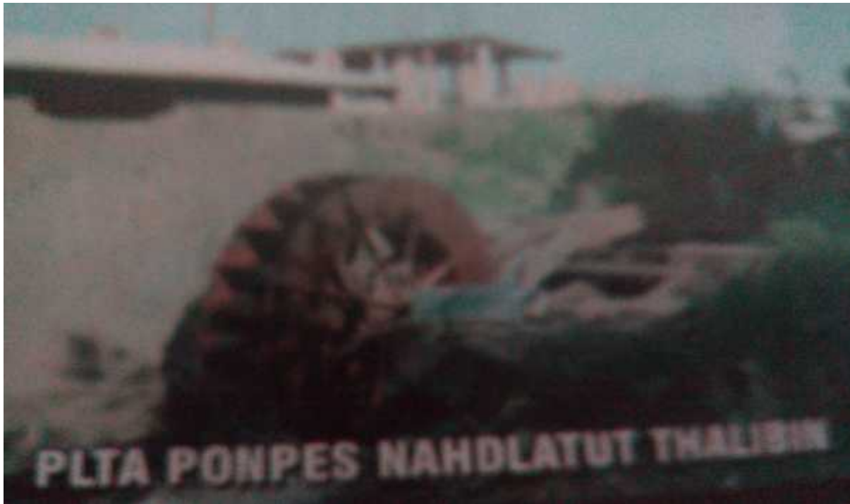
PLTA (Pembangkit Listrik Tenaga Air Nahdlatut Thalibin)
