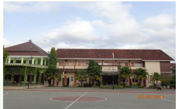
Masjid, Ruang Guru, dan Sekolah Tampak Dari Depan
