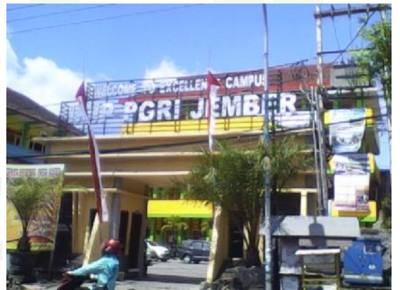
PINTU GERBANG IKIP PGRI JEMBER
