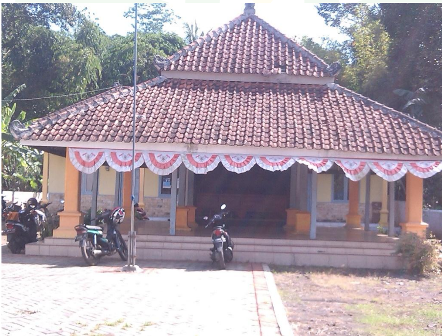
Kondisi balai Desa Tegal Ciut
