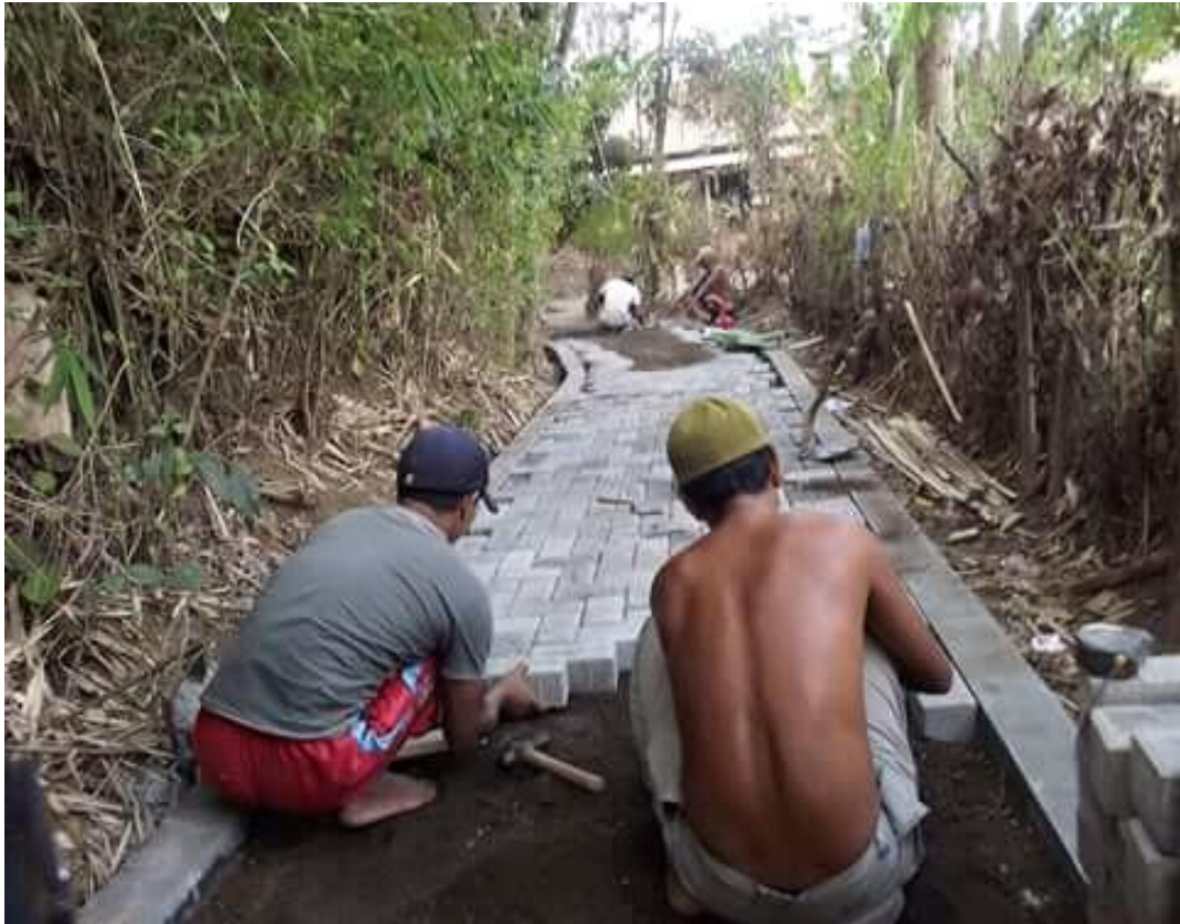
Program Paving Jalan Lingkungan
