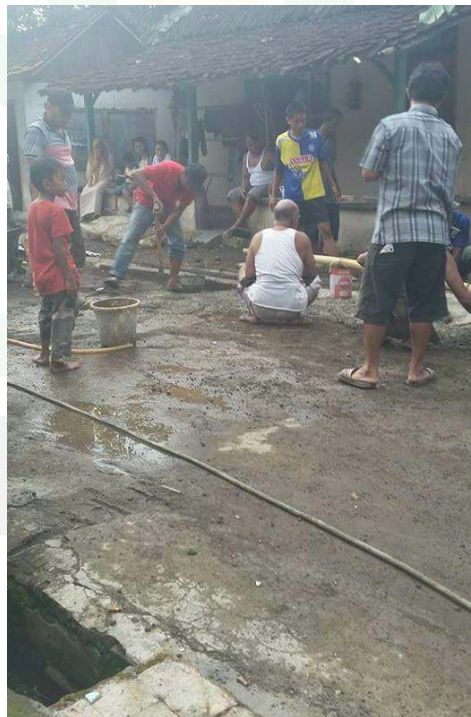
Gambar 2. Perbaikan Jalan dan Selokan
