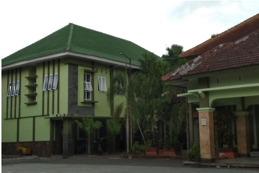
Gedung Asrama Putra
