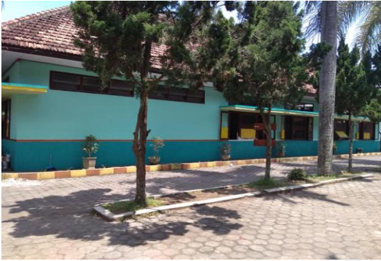
Gedung/Ruang Kelas SMPN 1 Pasirian Kabupaten Lumajang
