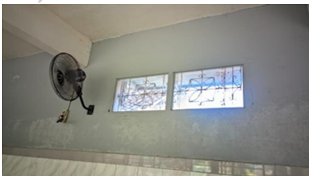
Gambar 4.3 kondisi dinding laboratorium yang sudah direnovasi
