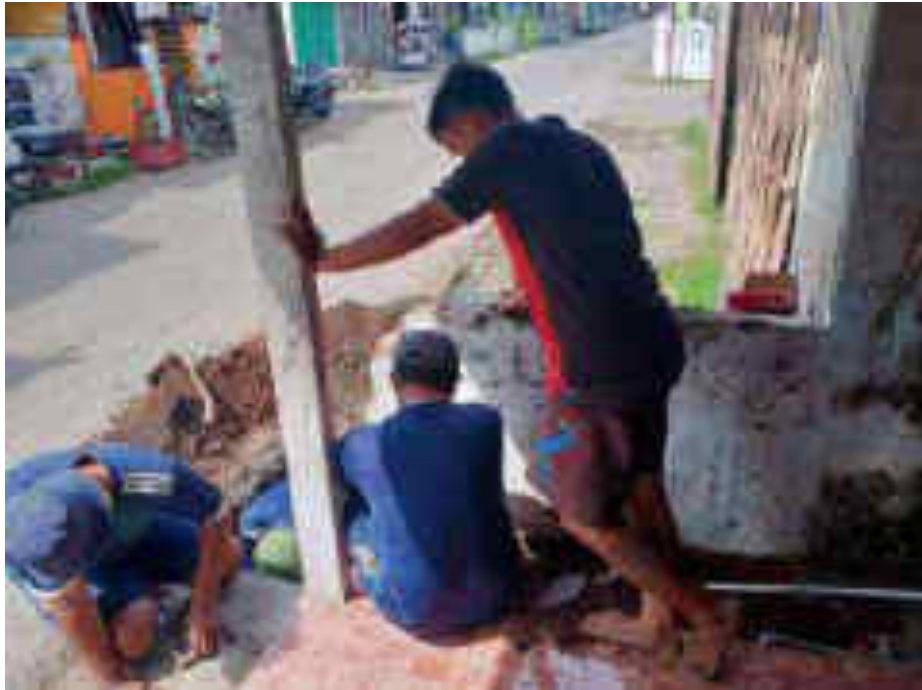
Proses Pemasangan Meteran Baru
