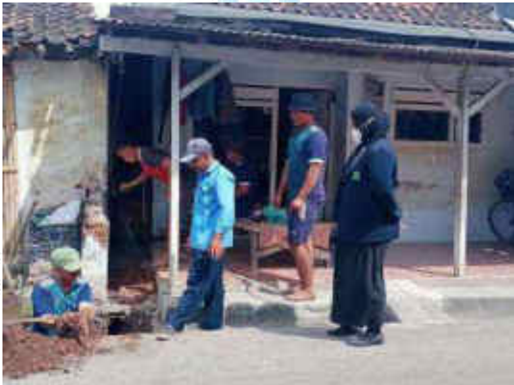
Proses Pemasangan Meteran Baru
