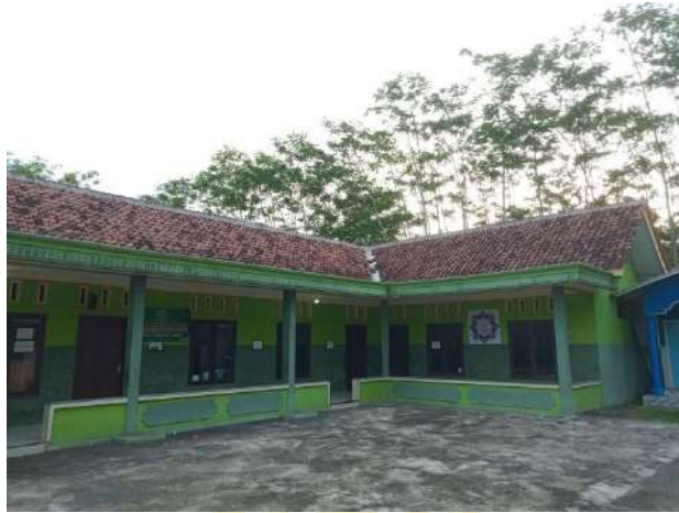
Kondisi bangunan TPQ Darunnajah
