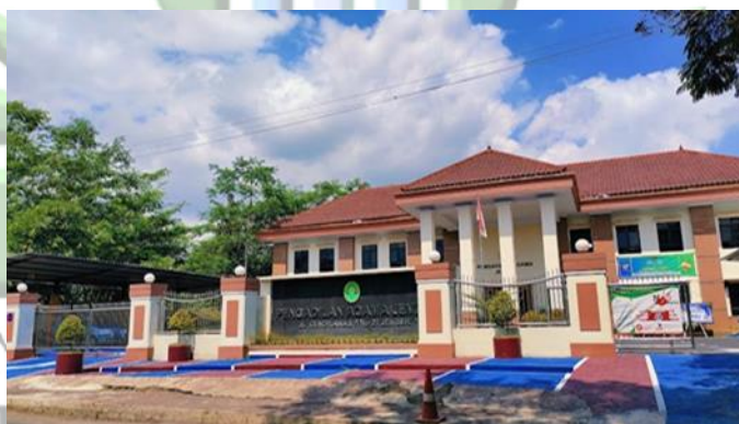
Gambar 4.1 Bangunan PA Jember Tampak Depan
