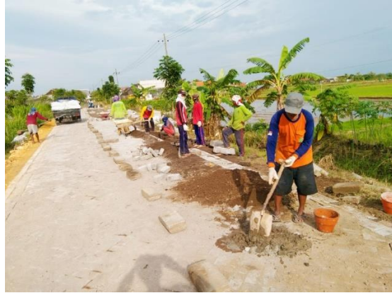
(Pembangunan perbaikan Jalan)
