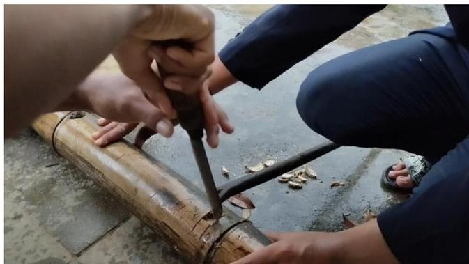
**Gambar 4. 9** Proses Pemberian Lubang Pada Bagian Ruas Paling Bawah
