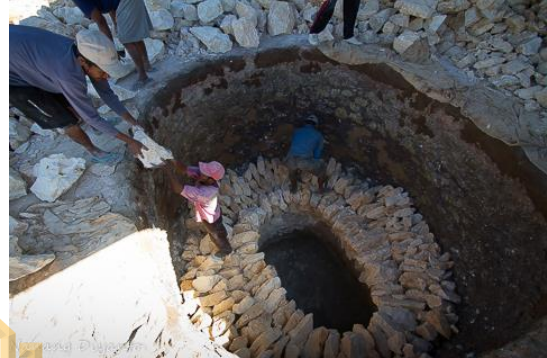
Penyusunan batu gamping
