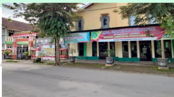
Gambar 4.3 Bangunan MTs Salafiyah Safi'iyah Mumbulsari tampak dari luar 77
