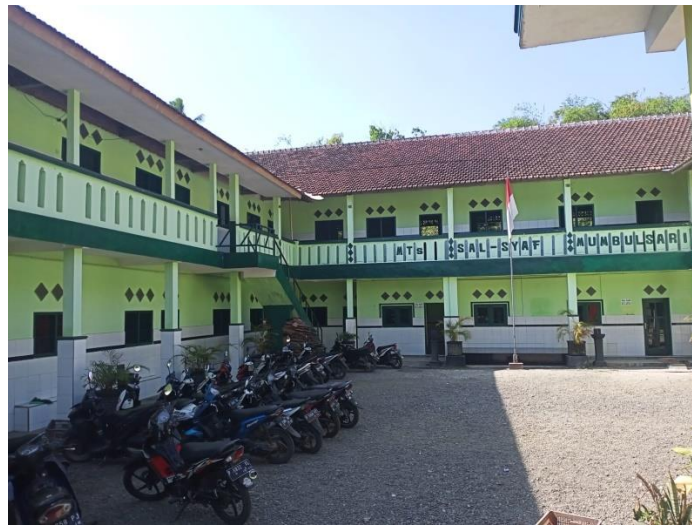
Bangunan MTs Salafiyah Safi'iyah Mumbulsari
