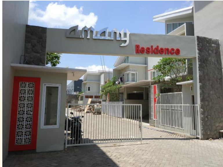
Dokumentasi Gapura perumahan Amany Residence Jember
