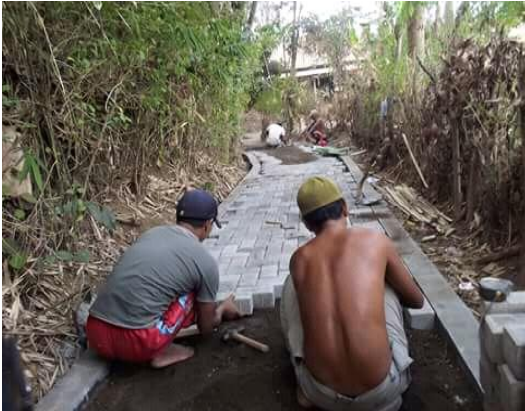
Program Paving Jalan Lingkungan
