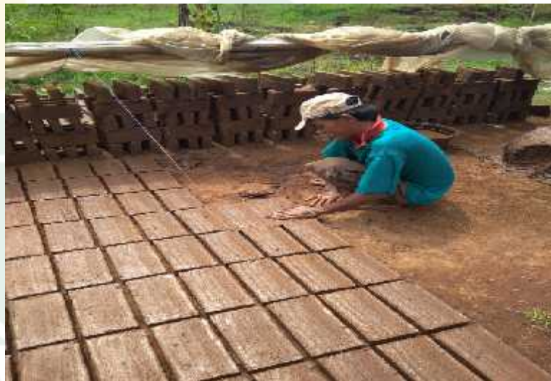
Foto pada saat pekerja mencetak batu bata.
