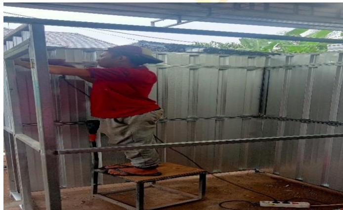
Pemasangan baut menggunakan bor oleh mas arif
