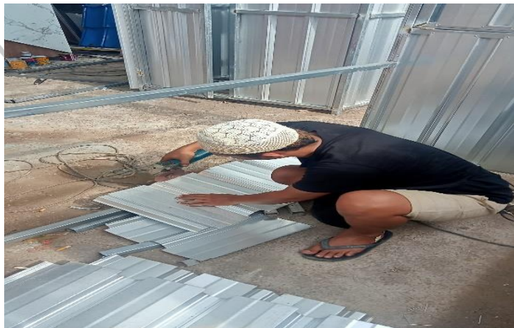
Pemotongan besi holo untuk kerangka booth container
