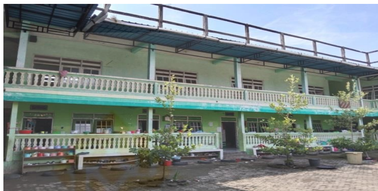
Gambar 4.13 Gedung Lantai atas nampak dari sebelah timur
