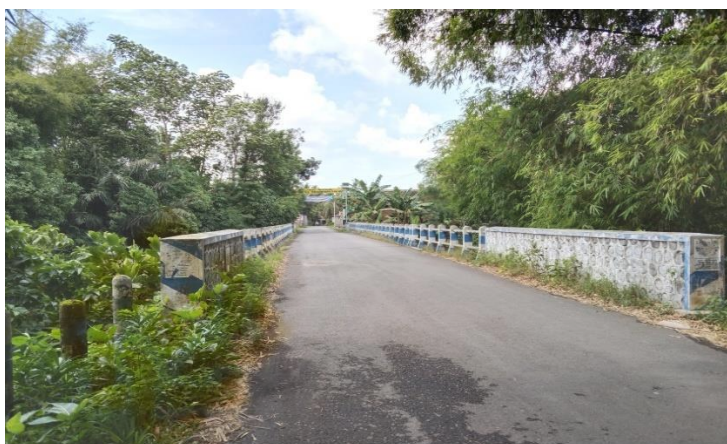
Gambar 4.20 Jembatan selatan Pondok Pesantren 203
