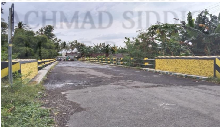
Gambar 4.19 Jembatan Wringin Putih 202
