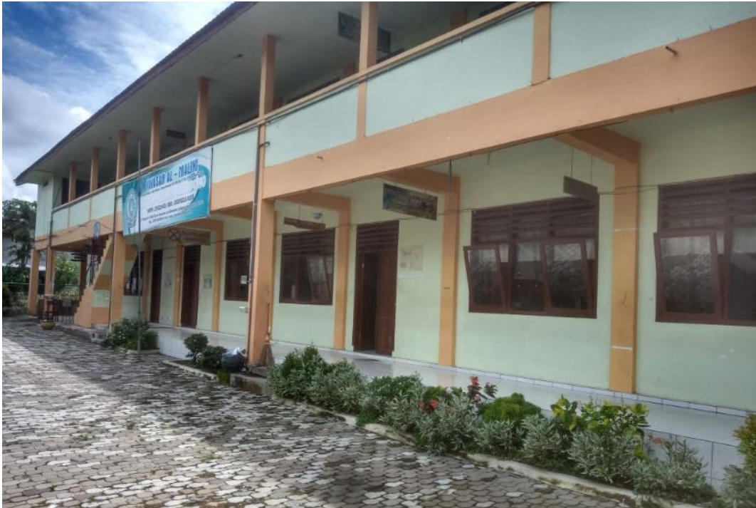
Gambar 7 Gedung SMP Al-Maliki
