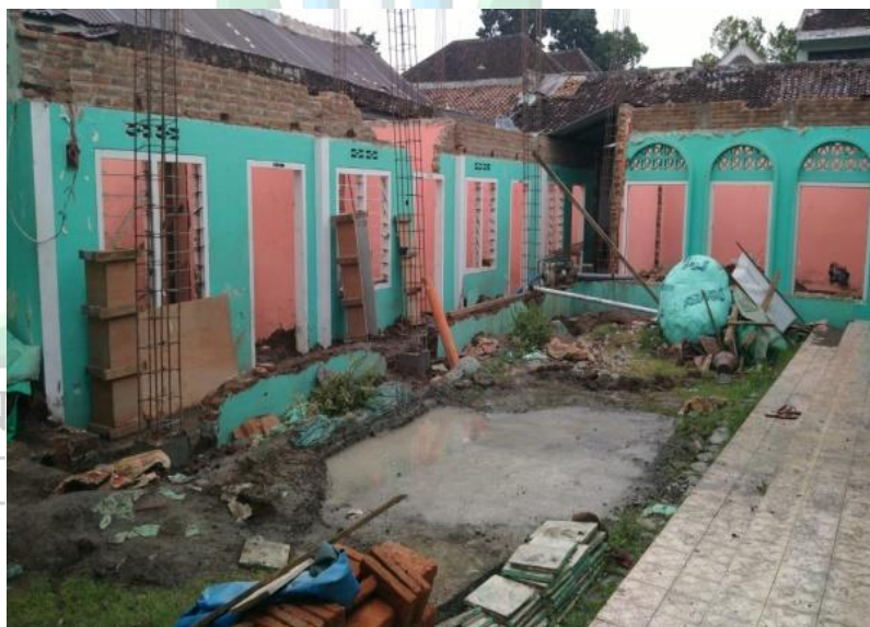
Gambar 3.2 Proses renovasi kedua bangunan asrama santri Pondok Pesantren Azzahro
