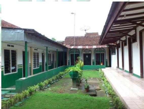
Gambar 3.1 Bangunan tempat tidur (asrama) santri Pondok Pesantren Azzahro setelah renovasi pertama.
