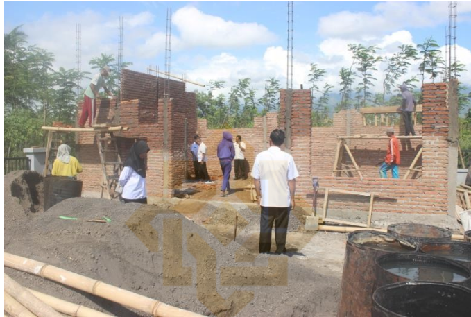
Gambar: Pembangunan Gedung Serbaguna Pusat Informasi Megalitikum Bondowoso
