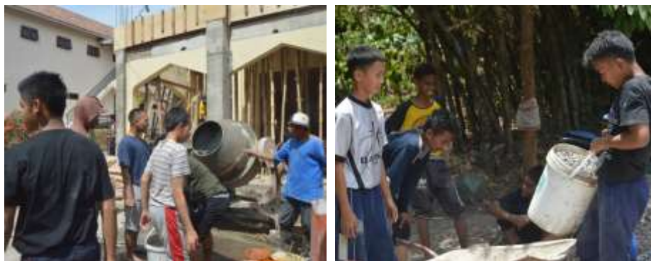
Gambar 4.5 Santri membantu pembangunan Pondok Pesantren Darul Istiqomah
