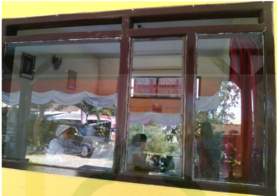
Ventilasi kelas di SLB-A Bintoro Patrang Jember
