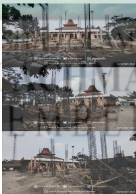
Gambar 4.4 Pembangunan Masjid Jami' Baitul Arqom
