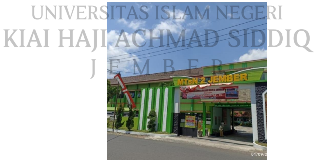
Gambar. 4.1 Tampak Depan MTs Negeri 2 Jember
