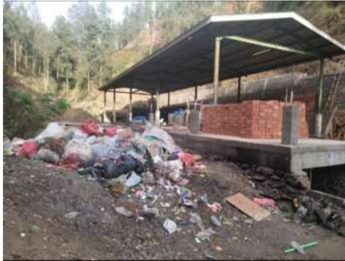
Gambar 4.5 Pembuatan Tempat Pembuangan Sampah (TPS)
