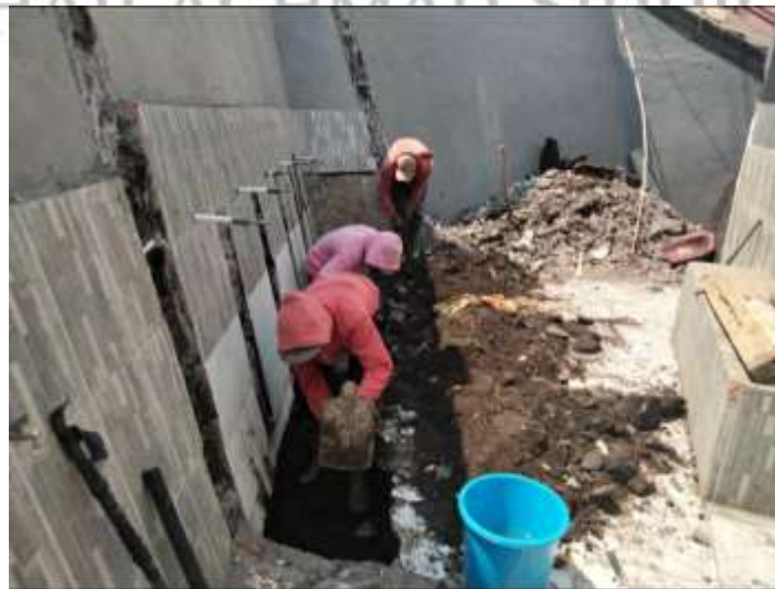
Gambar 4.4 Pembuatan Toilet Umum
