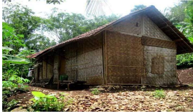
Gambar 65. Rumah Tidak Layak Huni
