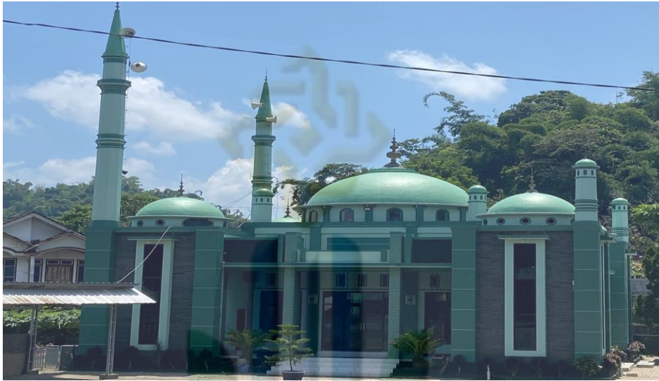
Bangunan Masjid Al-Muhajirin setelah renovasi
