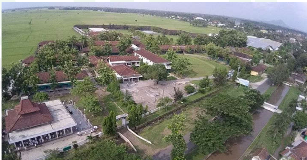
Gambar 4.1. Lokasi dan Kondisi Pesantren Baitul Arqom
