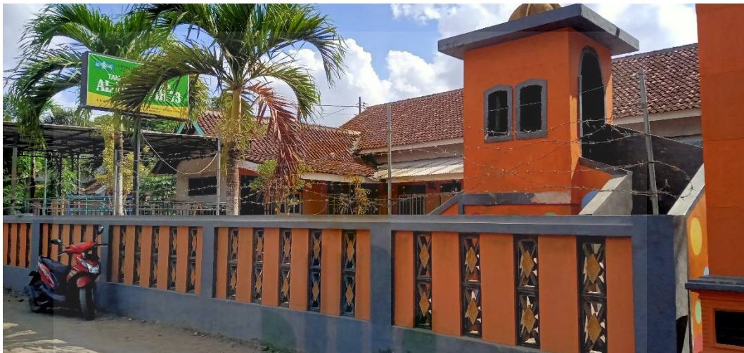
Gambar Gedung TK Al-Hidayah 73 Jember
